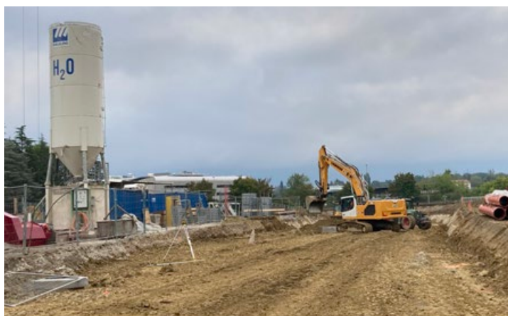
Chantier des infrastructures de l'écoParc des Cherpines
