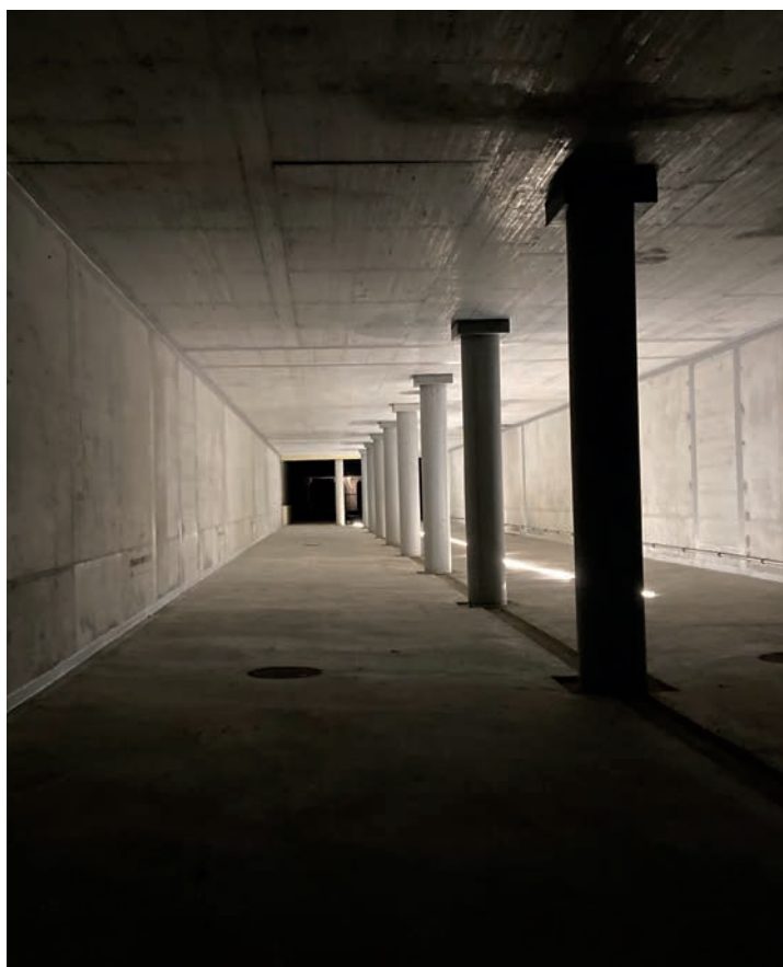
Bassin de rétention de la Galaise
