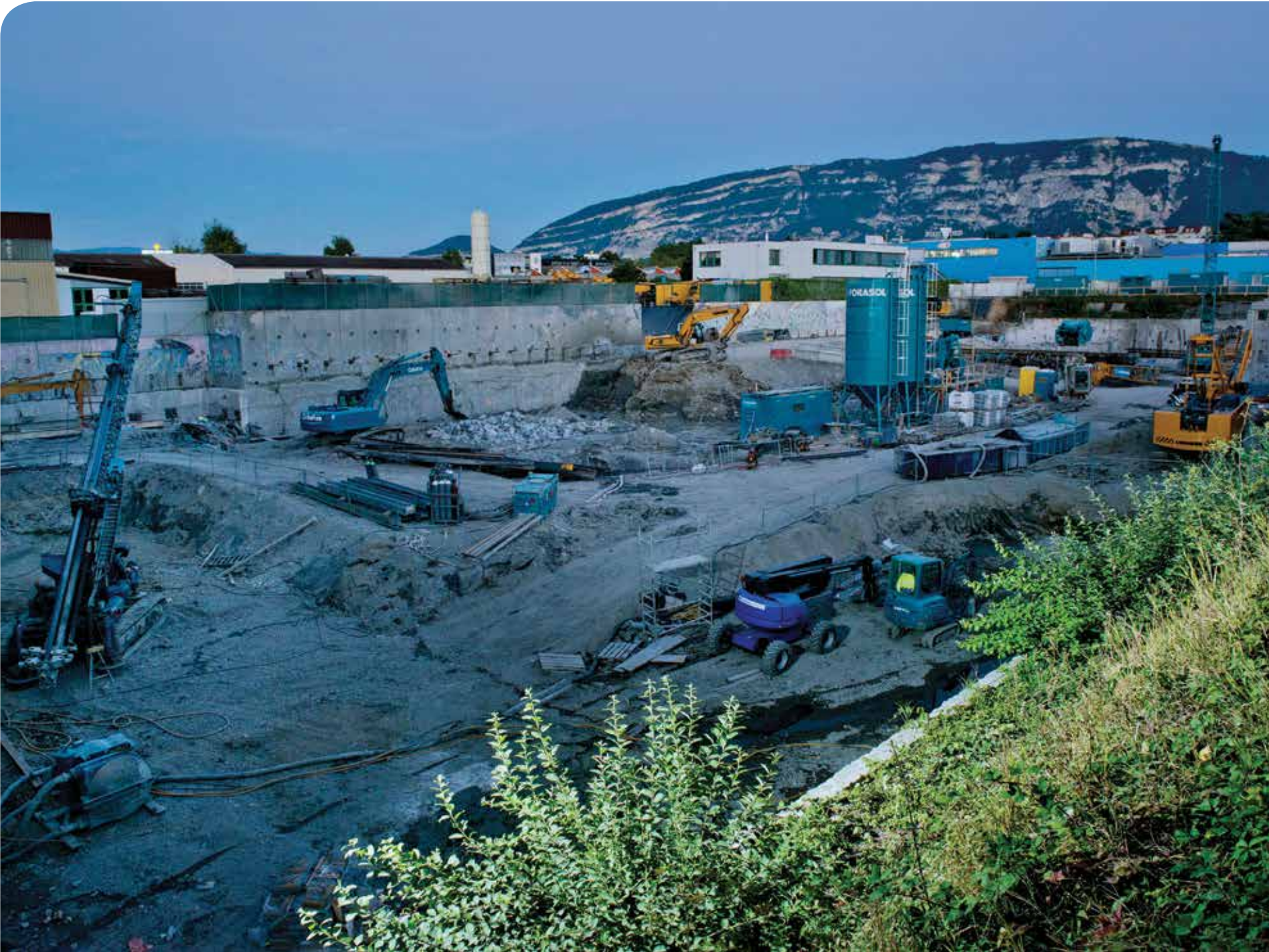
Photo : ZIPLO, chantier chemin du Pré-Fleuri
